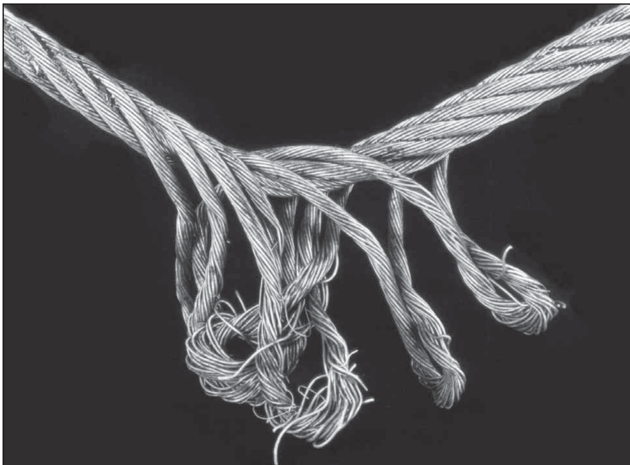
Figur 107: Dette ståltauet er blitt åpnet . De ytre partene har blitt for lange i forhold til resten av ståltauet. En skive har skjøvet de "overflødige" partene til endepunktet.
