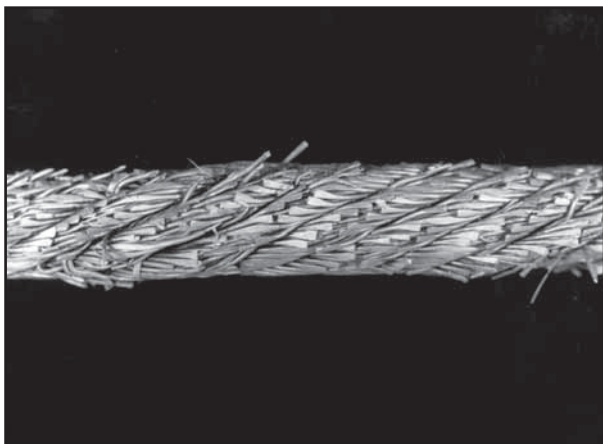
Figur 112: Dette ståltau har arbeidet i en låst skive.
